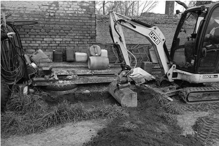
Prace ziemne wykonywane przy pomocy koparki. Fot. M. Żak
