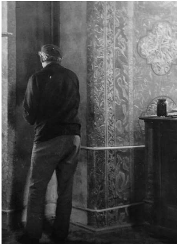
Borys Woźnicki przy pracach restauracyjnych stiuków w zamku w Olesku. Z archiwum L. Anczyszkiny
