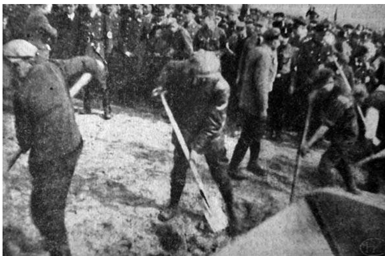
Pierwszy wagon z ziemią zostanie wkrótce załadowany. „Liegnitzer Tageblatt”, nr 69 z 22 III 1934. Źródło: zbiory Archiwum Państwowego we Wrocławiu Oddział w Legnicy. Fot. A. Miernicki
