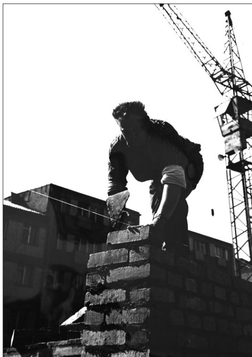
Zdj. 3. Tak budowano Rynek 44. 1957 r. Autor: M. Pawelek. Zbiory APL.
